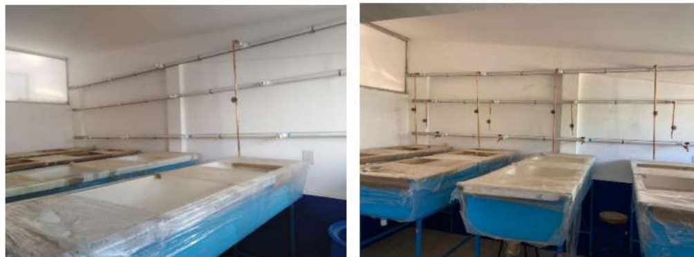
Figura 3 instalación de tuberías del área de eclosión y alevinaje
